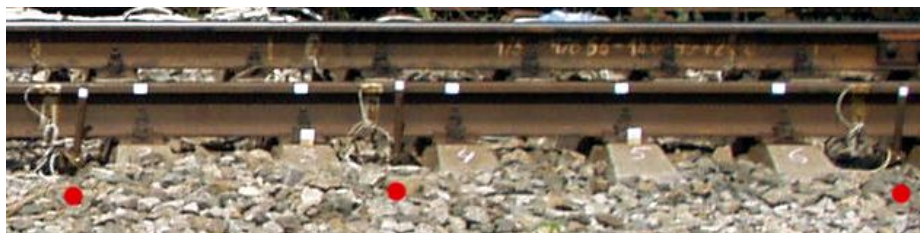
Рис. 2. Послідовність трьох перерізів рейки, обладнаних датчиками
